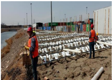
图 2-17-5 MABR 系统施工现场图片
