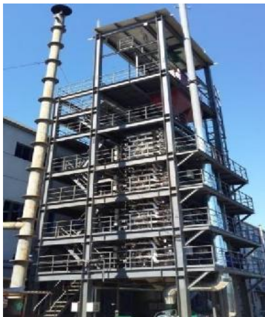
图 2-12-3 生物质热解装置
