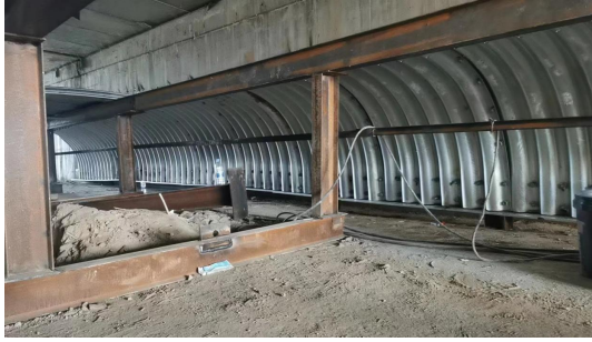
图 1.3 波纹钢拼装
