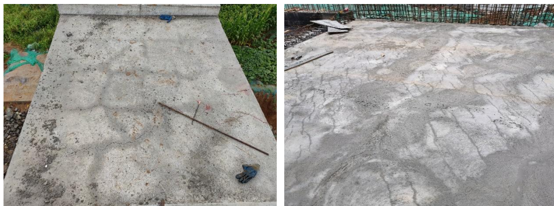
图5 混凝土早期塑性收缩裂缝
