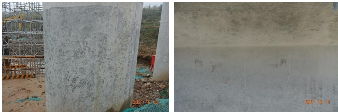
图4 某墩柱砂线（左）和某预制箱梁梁端竖向裂缝（右）
